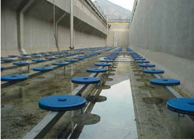
Die Membranen der ELASTOX®-T Tellerbelüfter bestehen aus einem Spezial-Kautschuk (EPDM) oder Spezial-Silikon, die sich schon in vielen Anlagen bewährt haben.
